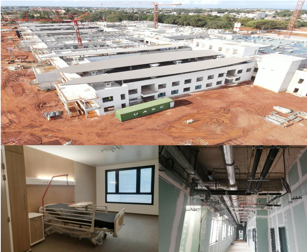
Image du Centre Hospitalier et Universitaire de Référence (CHUR) d'Abomey-Calavi, Hôpital de référence en cours de construction par BOUYGUES BATIMENT
