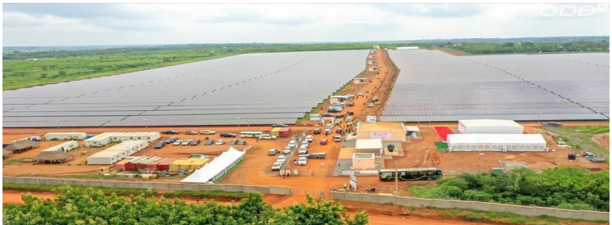
Centrale Solaire de 25 MGW de la Société Béninoise d'Énergie Électrique (SBEE).
